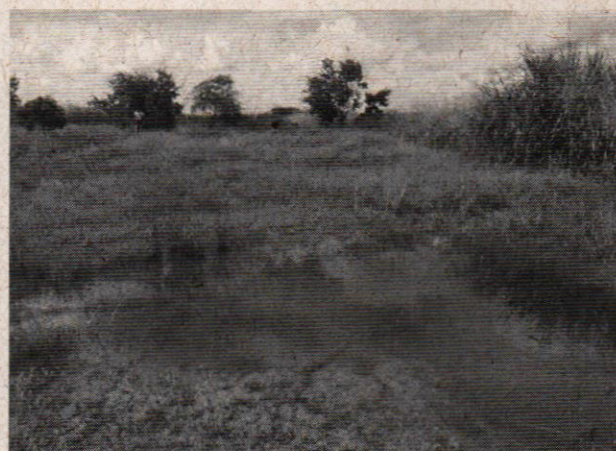
Foto 14 - Formação de "piscinas" sobre a manta da vala finalizada
