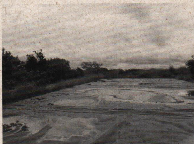
Foto 11 - Formação de "piscinas" sobre a manta da vala finalizada
