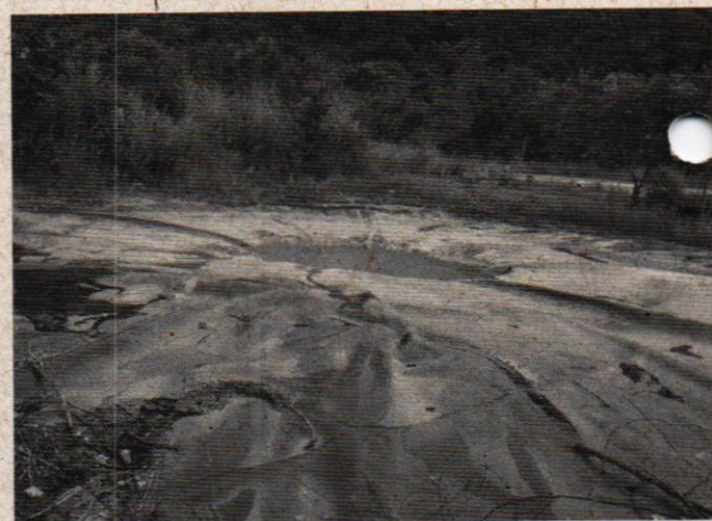
Foto 12 - Formação de "piscinas" sobre a manta da vala finalizada
