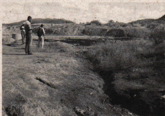
Foto 5 – Processos erosivos pela falta de bacia de acumulação
