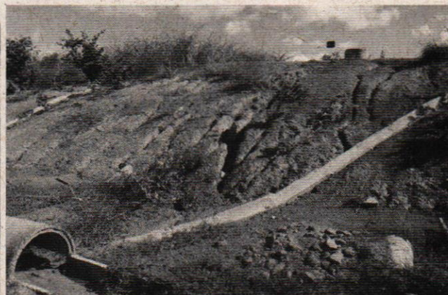
Foto 4 – Processos erosivos nos taludes
