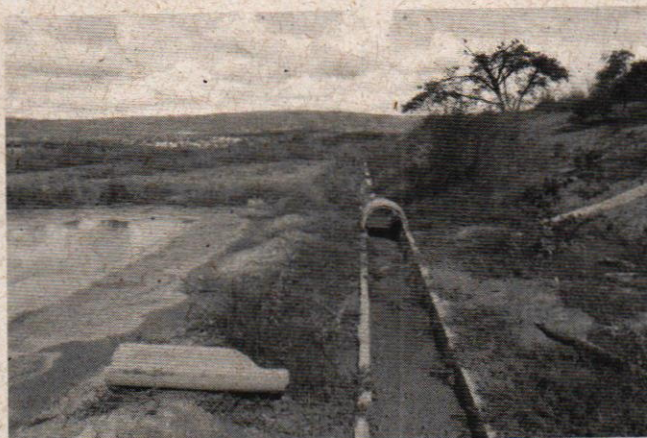
Foto 7 - Assoreamento do sistema de drenagem de águas pluviais
