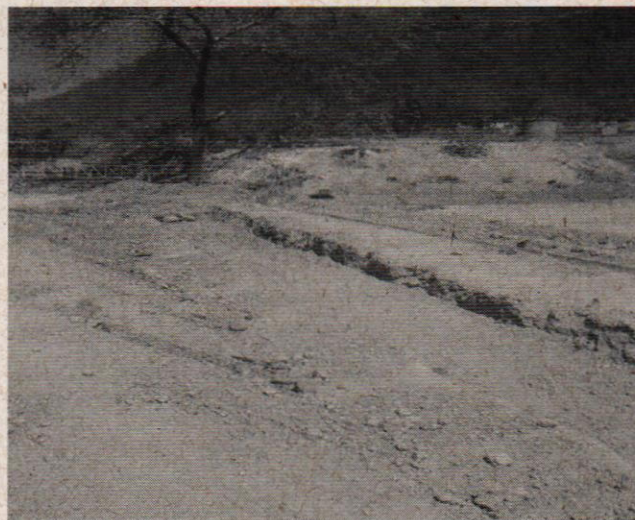
Foto 2 – Falta de sistema de drenagem de águas pluviais
