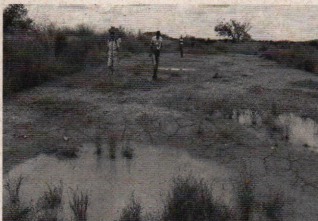
Foto 13 - Formação de "piscinas" sobre a manta da vala finalizada
