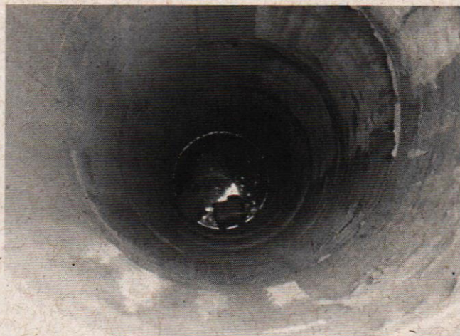
Foto 20 - Resíduos dentro dos poço dos drenos testemunhos
