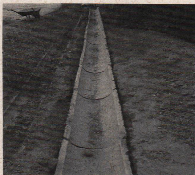
Foto 2 - Implantação do sistema de drenagem de águas pluviais
