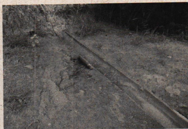
Foto 8 - Assoreamento do sistema de drenagem de águas pluviais
