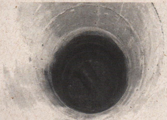
Foto 19 - Resíduos dentro dos poço dos drenos testemunhos
