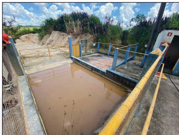
FOTO 17 – Tratamento do efluente do lavador de veículos.
