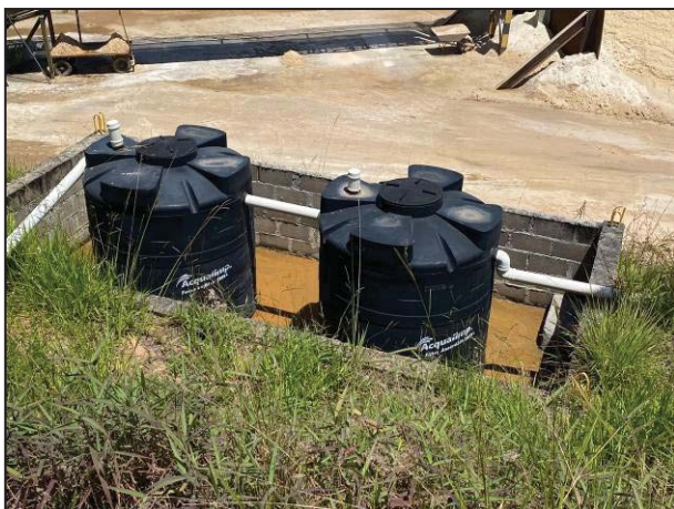
FOTO 16 – Sistema fossa séptica e filtro anaeróbio.
