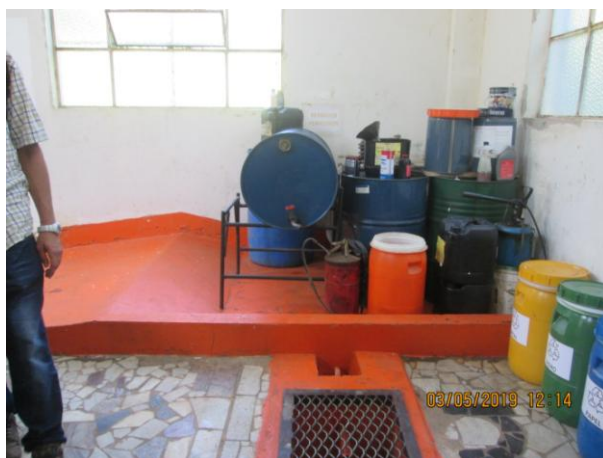
Armazenamento de resíduos sólidos, contenção para os de Classe I
