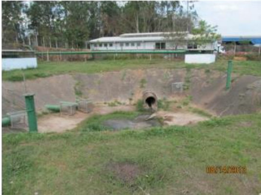
Foto 5 - Bacias para armazenamento de água em excesso e Estação de Bombeamento
