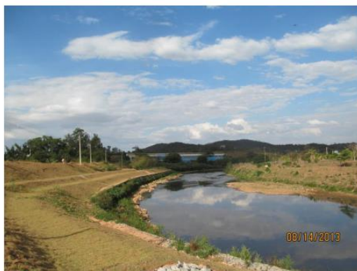
Foto 4 - Dique concluído e margem reabilitada
