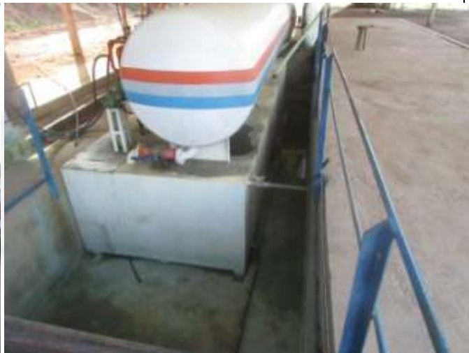
Foto 02: Autoclave em bacia de contenção
