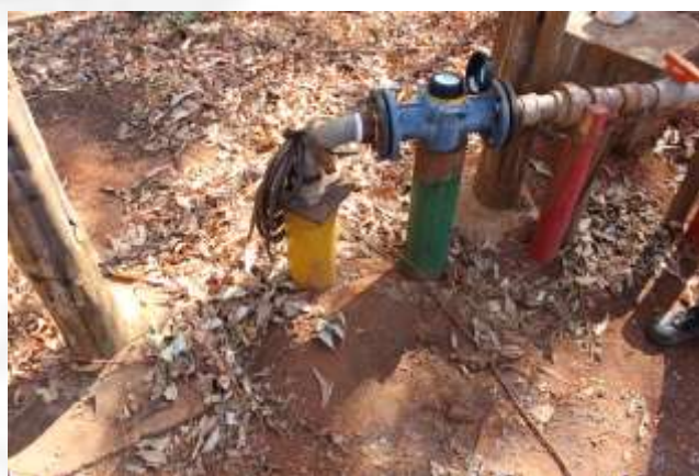
Foto 02: Poço tubular. (Portaria nº 2216/2004)
