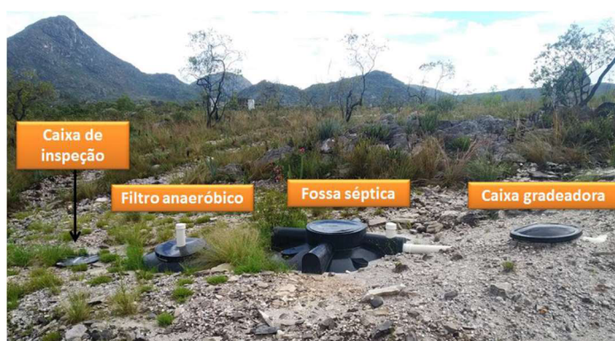
Imagem 03 – Exemplo de sistema de tratamento de efluentes sanitários a ser instalado
