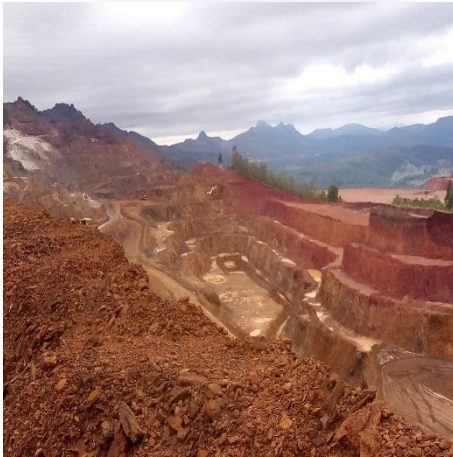
Foto 1: Cava em operação
