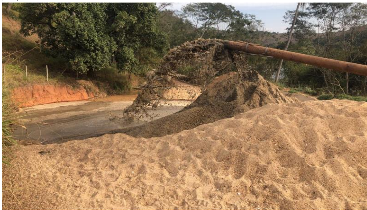
Disposição da areia diretamente da draga para o solo
