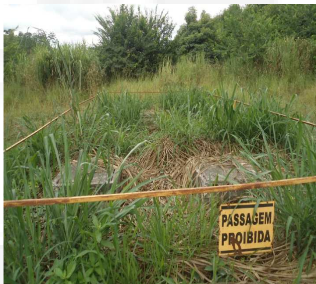
Foto 04. Sistema de tratamento de efluentes sanitários.
