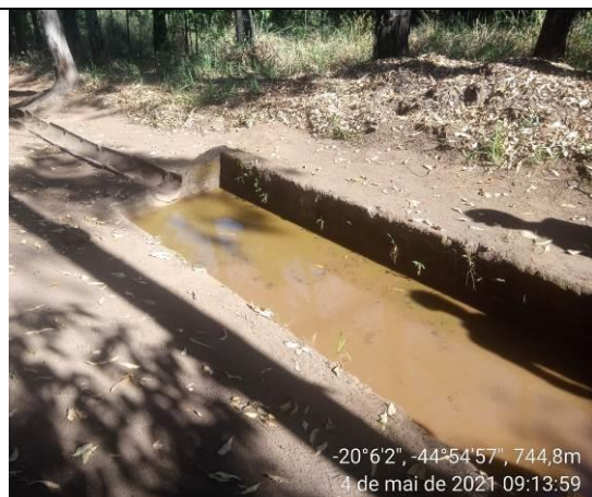
Foto 07. Canaletas e tanque de decantação efluentes pluviais
