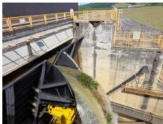
Figura 48. Print da figura 7 – modelo da comporta segmento com basculante previsto para o barramento da PCH apresentado como resposta ao Ofício SEMAD/SUPRAM SUL - DRRR nº. 77/2020.
