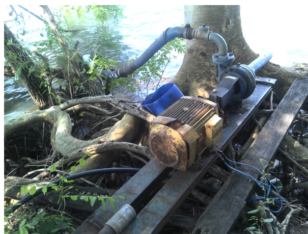
Figura 2. Captação de água
