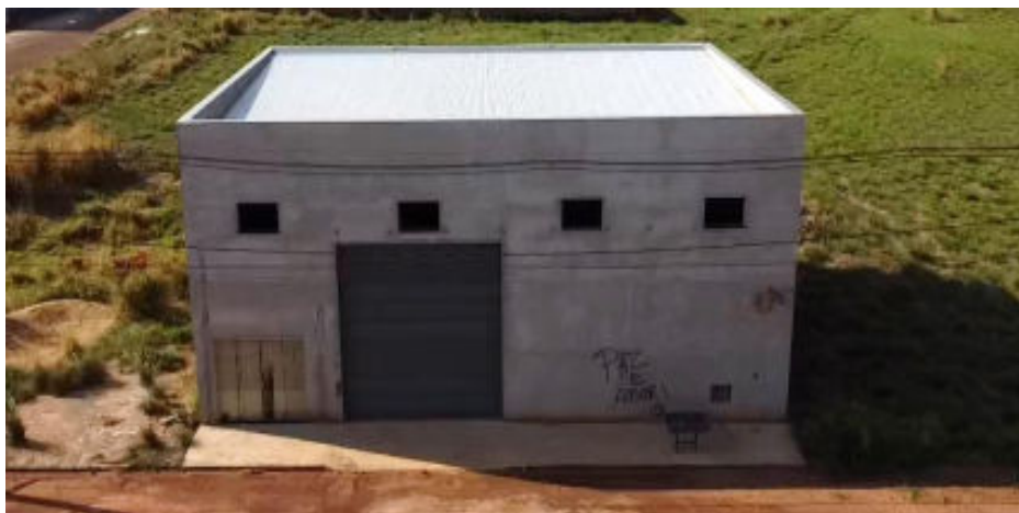
Barracão industrial destinado à instalação do empreendimento.
