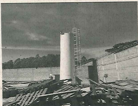
Foto 06. Reservatório de água
