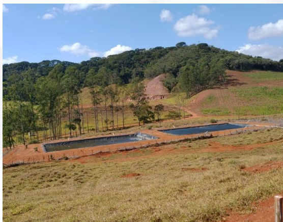
Imagem 03 e 04: caixa de contenção de sólidos e lagoas anaeróbias.
