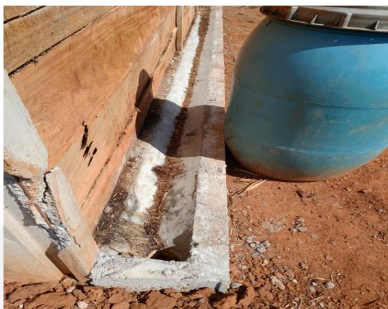
Imagem 05 e 06: composteira com canaleta para contenção de chorume.
