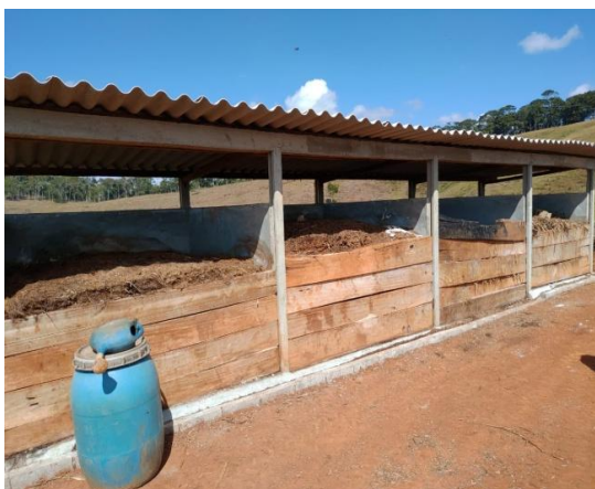
Imagem 05 e 06: composteira com canaleta para contenção de chorume.
