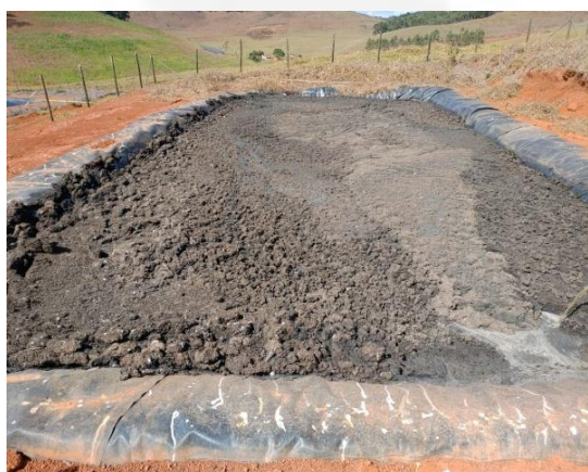
Imagem 03 e 04: caixa de contenção de sólidos e lagoas anaeróbias.
