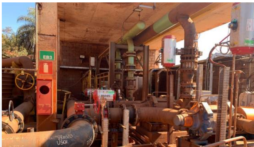
Figura 3.14: Novas bombas na estação de bombeamento EB-03. Fonte: Informações complementares, 2023.
