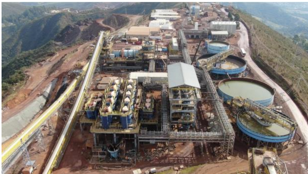
Figura 3.9: Flotação e Deslamagem. Fonte: Informações complementares, 2023.
