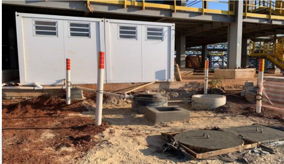
Figura 3.6: Sistema de coleta de efluentes sanitários do Escritório da Filtragem de Rejeitos.
