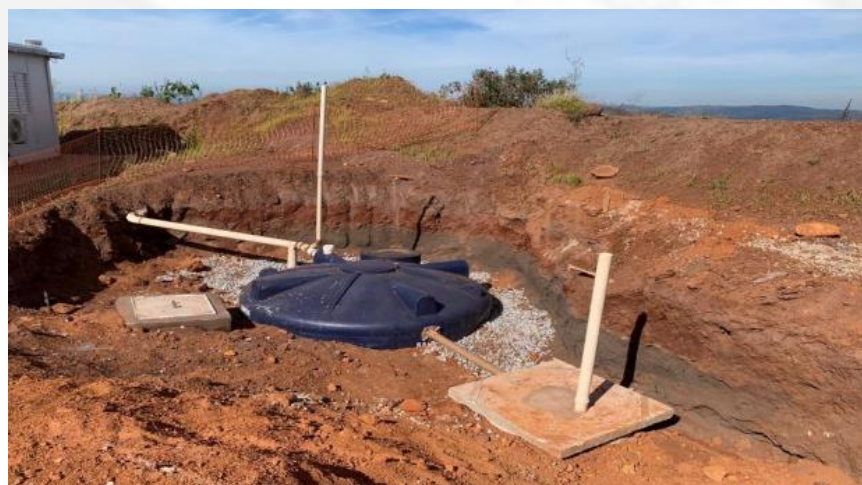
Figura 3.5: Sistema de coleta de efluentes sanitários dos escritórios de Operação e Manutenção. Fonte: Informações complementares, 2023.
