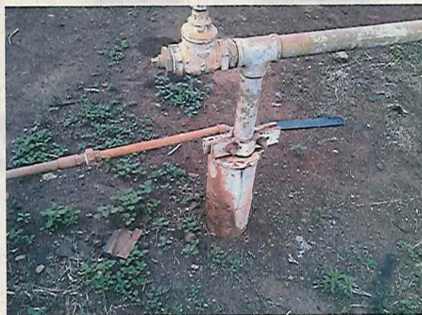
Figura 2. Captação de água por meio de poço tubular
