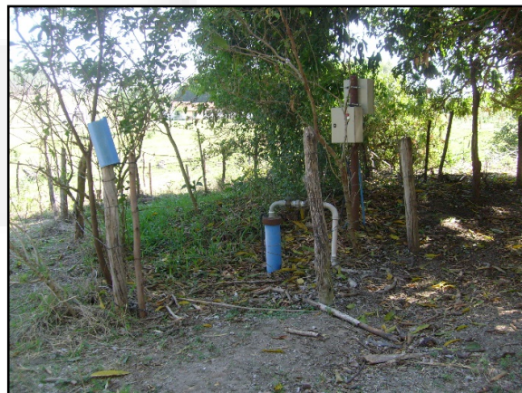
Foto 08. Poço tubular 02 instalado.
