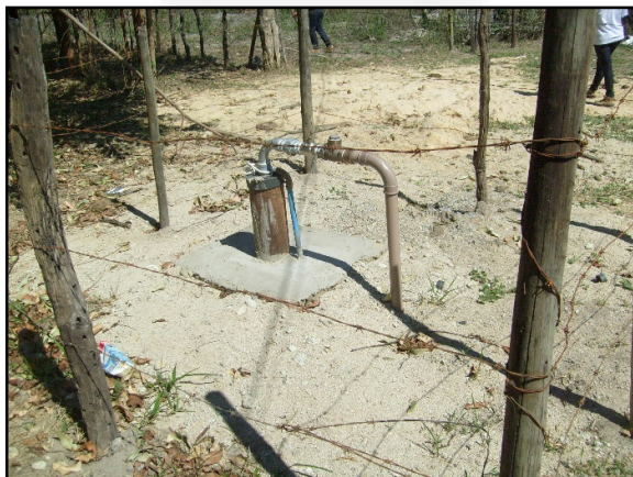
Foto 07. Poço tubular 01 instalado.
