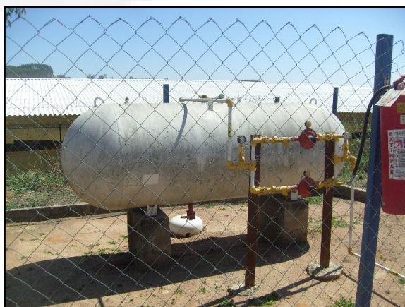
Foto 01. Reservatório de Gás de Liquefeito de Petróleo (GLP) ao lado de um galpão.
