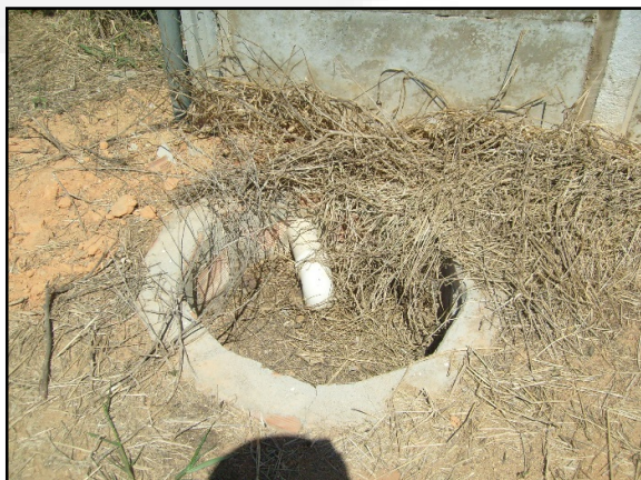
Foto 03: Caixa coletora de chorume instalada na Composteira.
