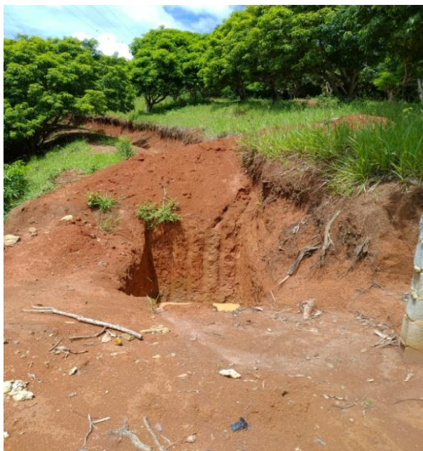
Foto 09: solo escavado para biodigestor.
