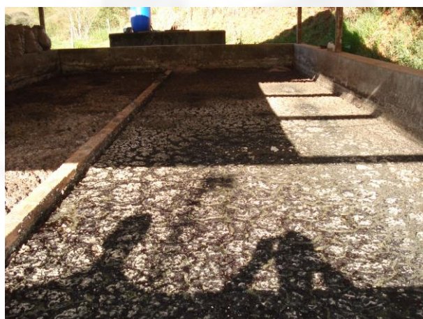
Foto 02. Leito de Secagem de Lodo da ETE
