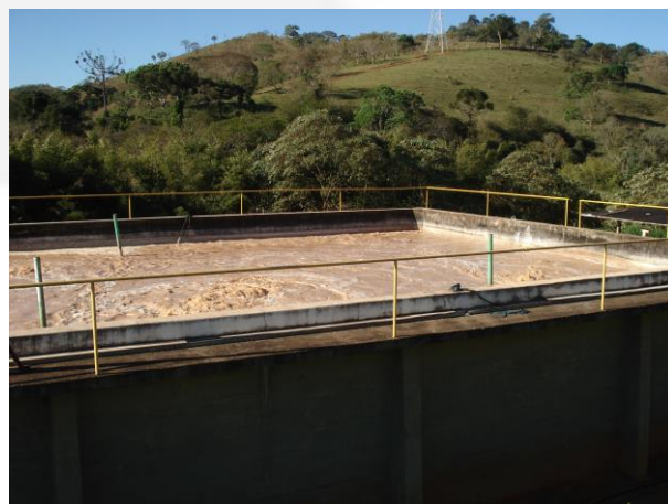
Foto 04. Tanque de Aeração da ETE
