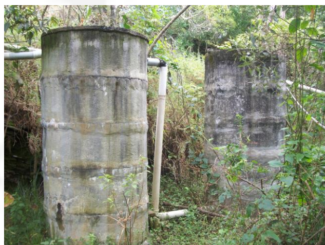
Foto 06. Sistema de tratamento de efluente sanitário com fossa séptica e filtro anaeróbio.
