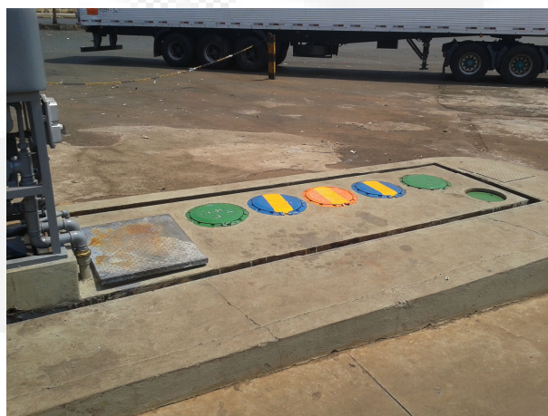
Foto 04. Descarga a distância e filtro de diesel
