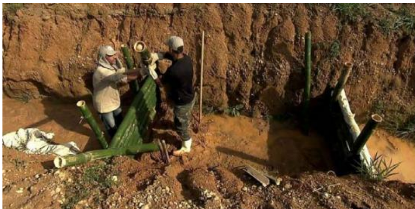
Figura 4: Exemplo de paliçada de bambu sendo instalada para contenção de processo erosivo.
