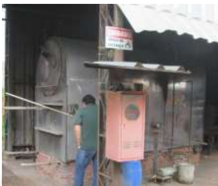
Figura 05: Caldeira de 1000Kg/h de vapor
