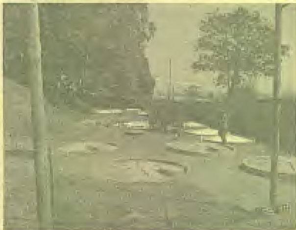
Foto 15: Estação de tratamento de efluentes líquidos.
