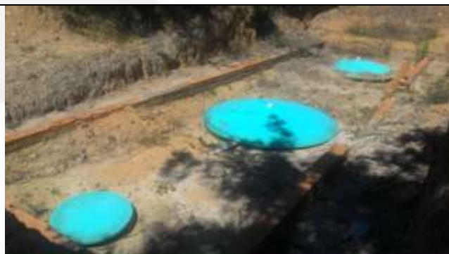
Sistema de tratamento de efluentes sanitários
