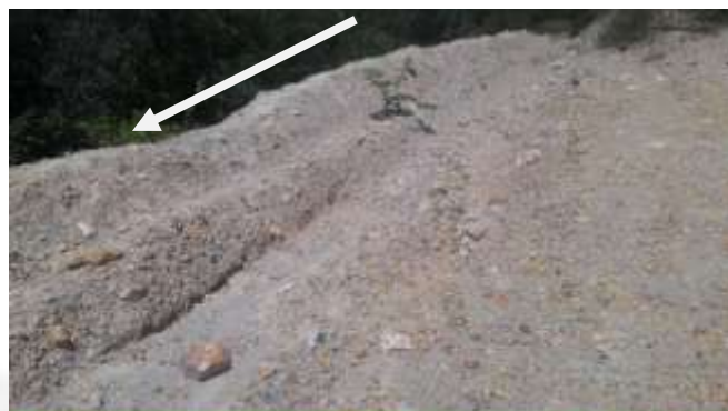
Barreiras implantadas próximo à frente de lavra 02 para evitar carreamento de sedimentos
