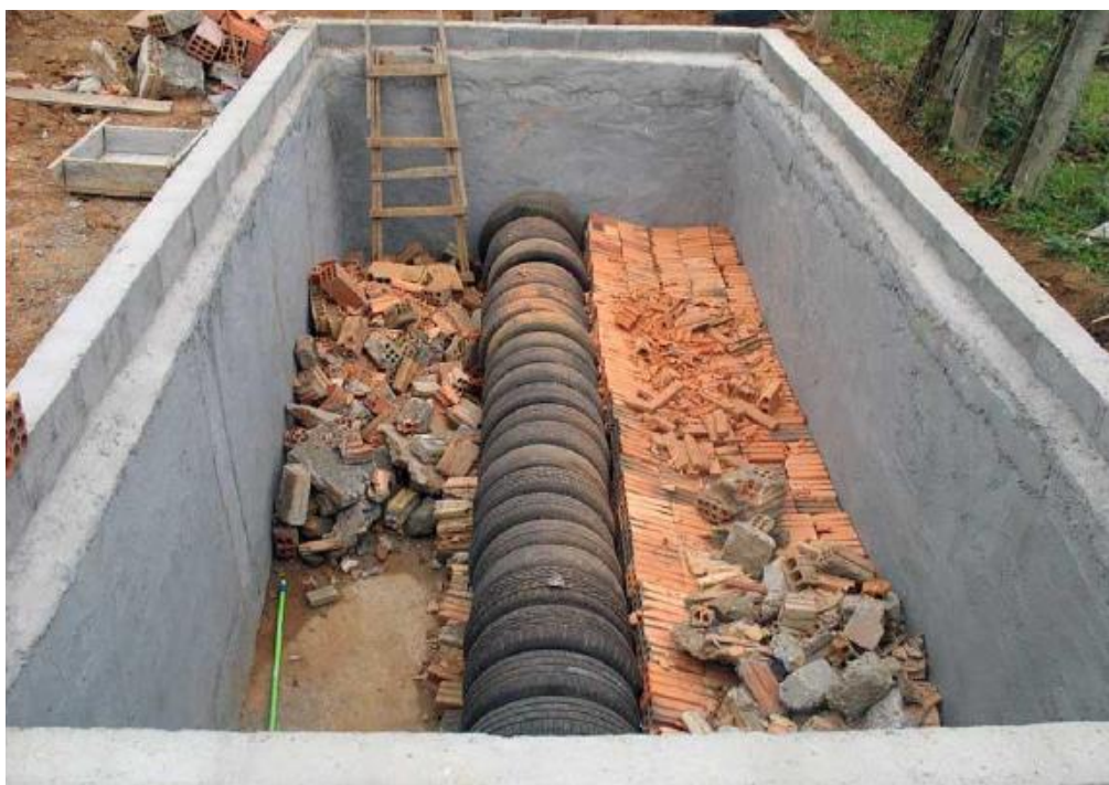
FIGURA 3 - Tanque de Evapotranspiração - TEvap. Fonte: SLA nº 584/2023 - Sistema de Tratamento de Efluentes Industriais e Sanitários
