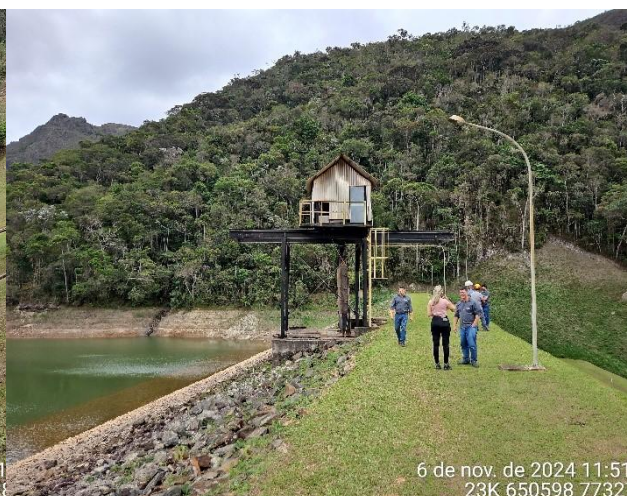
Foto 6: Casa de Controle das válvulas.
