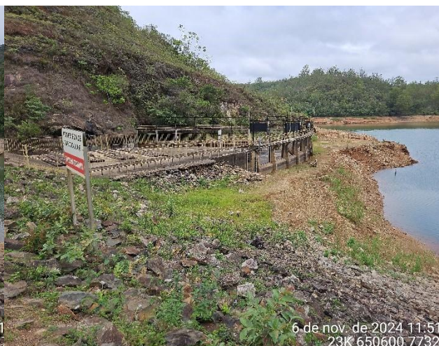
Foto 2: Vertedouro na parte alta do barramento.
