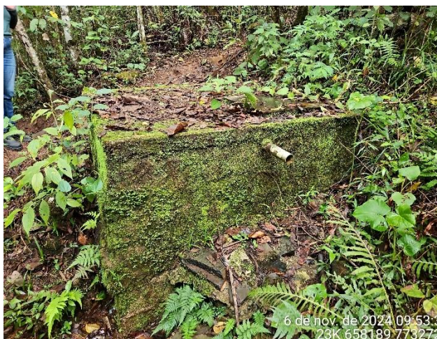
Foto 41: Ponto de captação de água para a CGH Caboclo.
