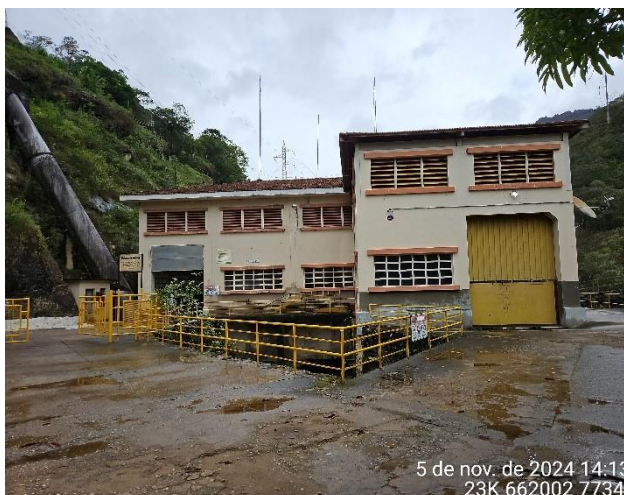
Foto 25: Casa de Força da CGH Funil.
