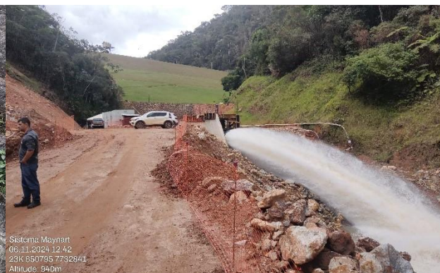
Foto 65. Feição 04 espeleológica verificada próxima às obras de substituição do extravasor. BRC. Foto 66. Ao fundo BRC, à esquerda acesso para manutenção/obras e no centro novo extravasor (em construção) para regulação do nível d'água da barragem.
