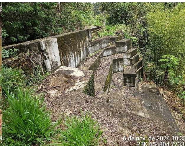
Foto 14: Estrutura de alvenaria construída para reconformação do canal e estabilização do talude.
