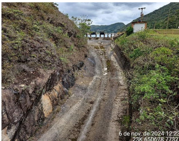
Foto 3: Rampa de vazão do vertedouro.
