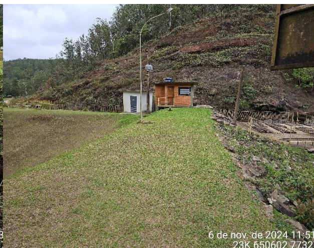
Foto 4: Casa de operação da barragem.
