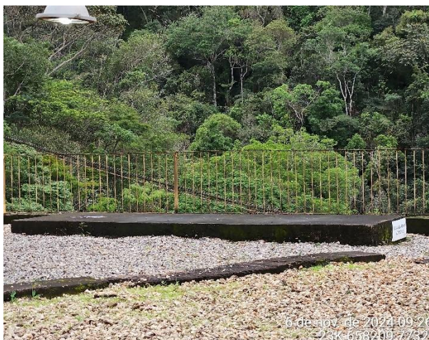
Foto 37: CSAO da Subestação Caboclo.
