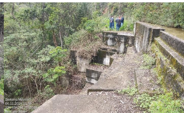
Foto 59. Canal de adução próximo ao encontro com o córrego do Forjo. Na encosta afloram litotipos do Grupo Maynart/ Complexo Antônio do Pirapetinga. Foto 60. Contenção de encosta associada ao canal de adução próximo ao córrego do Forjo.
