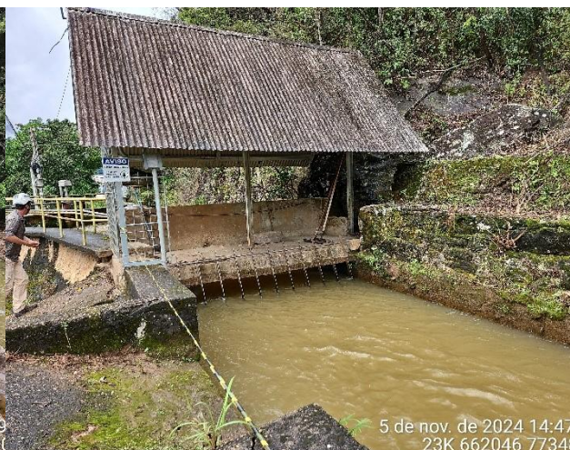
Foto 8: Ponto onde o canal chega ao conduto forçado. No local são instalados vertedouros para limpeza (à esquerda da foto), grades para retenção de material que possa vir a danificar a estrutura da turbina.
