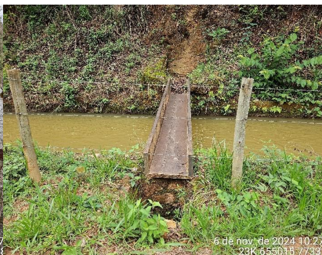
Foto 10: Bica para transposição de água de escoamento superficial.
