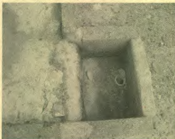
Foto 7: Canalização que encaminha efluentes da área de secagem para a ETE.
