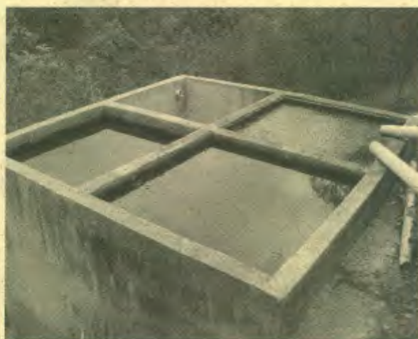
Foto 8: Sistema de tratamento de efluentes industriais.
