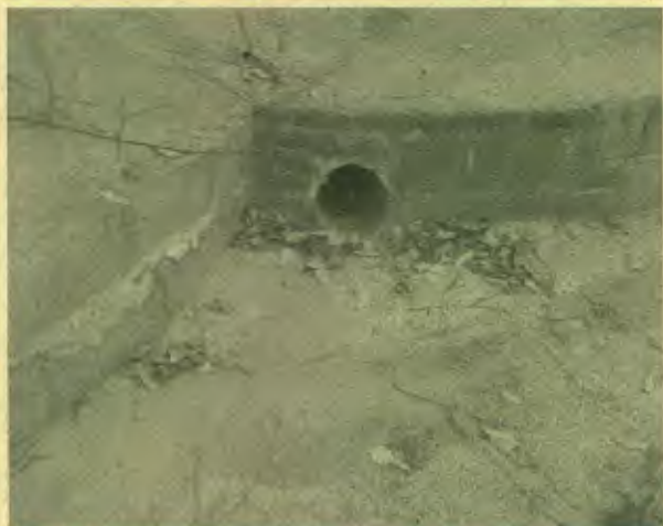
Foto 11: Sistema de drenagem pluvial.
