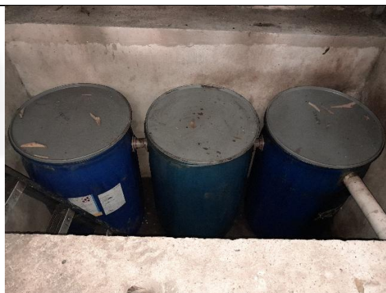
Figura 04: Sistema de Caixa Separadora de Água e Óleo (Caixa SAO).
