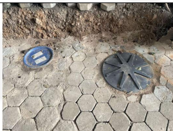
Figura 08: Sistema de tratamento de efluentes sanitários (Biodigestor). Fonte: Informação complementar Identificador (203985).
