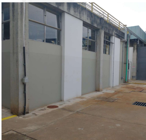
Foto 3 – Local da ampliação do WFI e vapor puro
