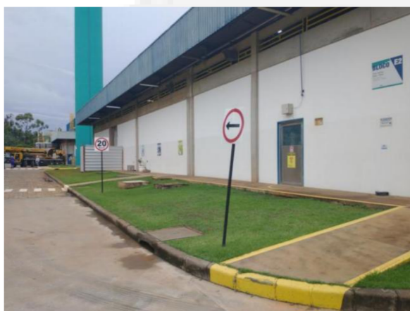
Foto 1 – Local da nova câmara fria - Bloco E
