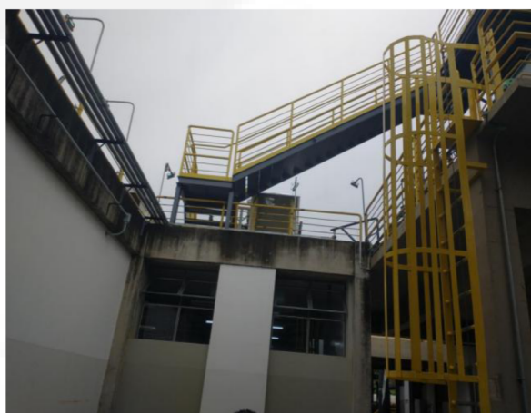
Foto 2 – Nova torre de resfriamento - Bloco CD
