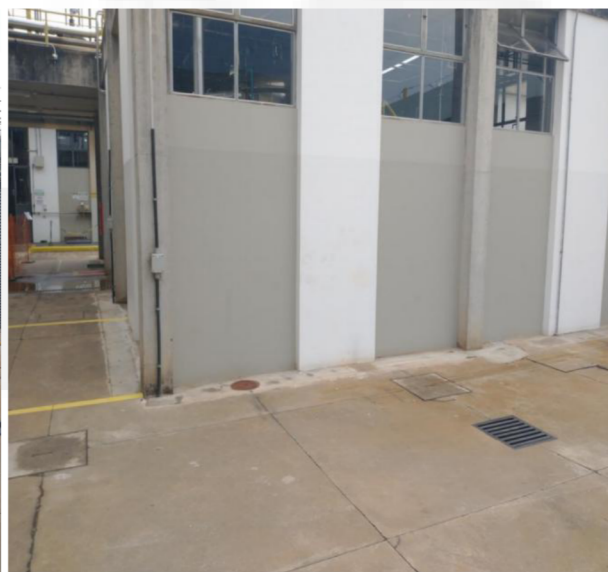
Foto 4 – Local da ampliação do WFI e vapor puro
