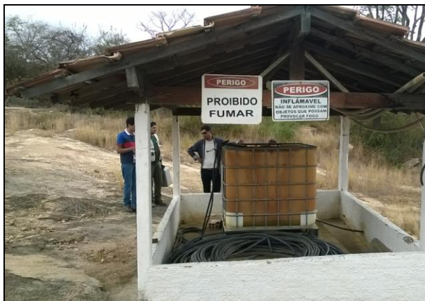
Foto 07: Tanque de abastecimento de diesel.
