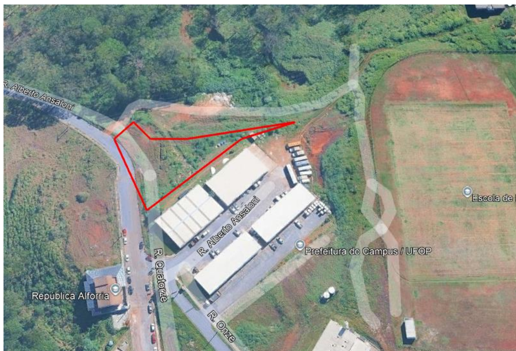
Imagem 01: ADA da ETE.
