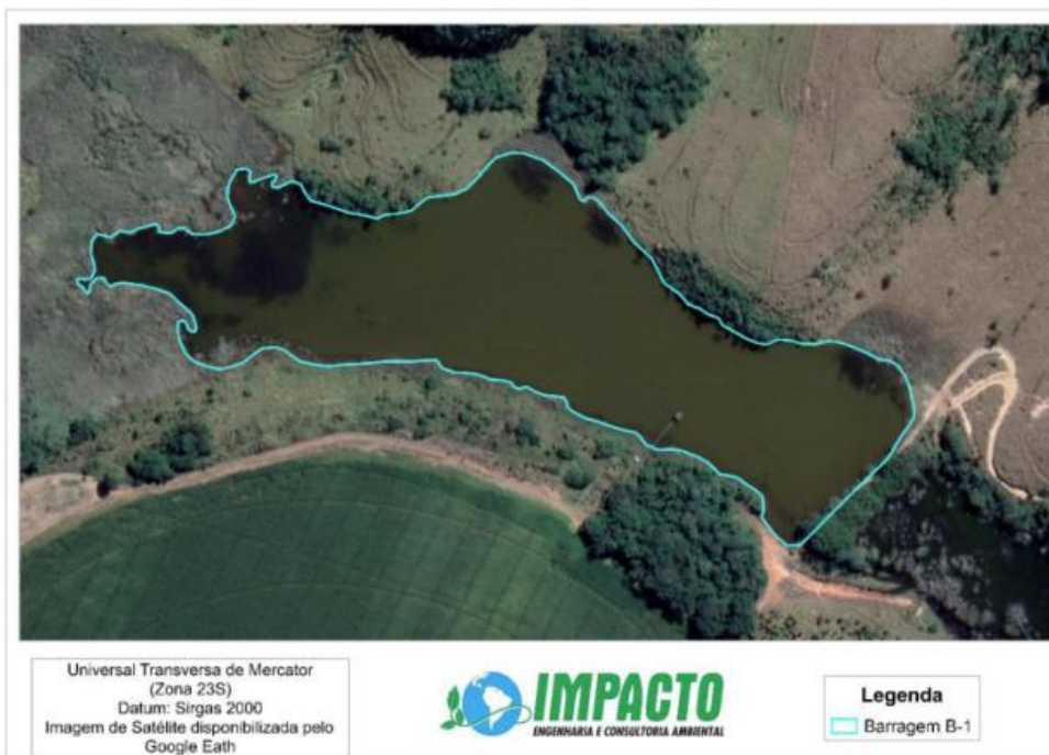
Figura 2: Área inundada da Barragem “B1”. Fonte: Autos do processo SLA n. 3595/2024.
