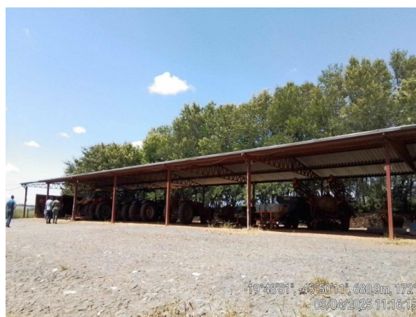
Foto 04. Oficina e pátio de abastecimento
