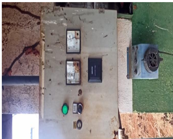
Foto 08 – Horímetro do poço tubular
