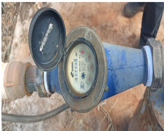
Foto 07 – Hidrômetro do poço tubular
