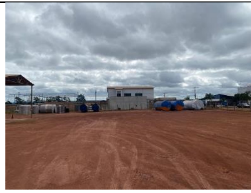
Figura 8. Pátio de acesso, manobras e estacionamento.
