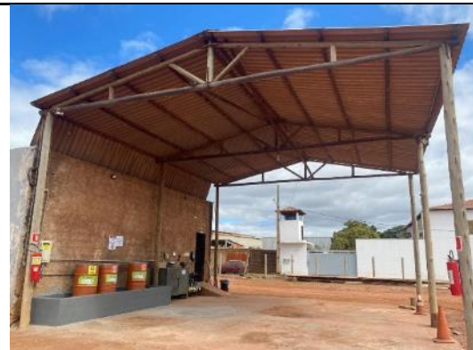
Figura 7. Galpão de resíduos e compressor de ar.
