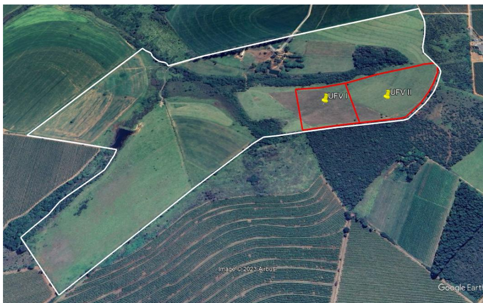
Figura 01: Vista aérea do empreendimento. Área de instalação da usina solar fotovoltaica (UFV), delimitada em vermelho. Fonte: Parecer técnico SEMMA nº 58/2023 .
