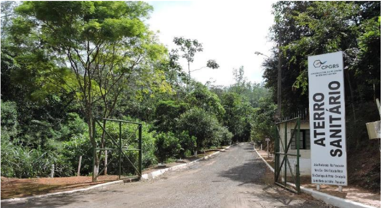
Foto 01: Portão e guarita de acesso do CPGRS – Aterro Sanitário de João Monlevade.
