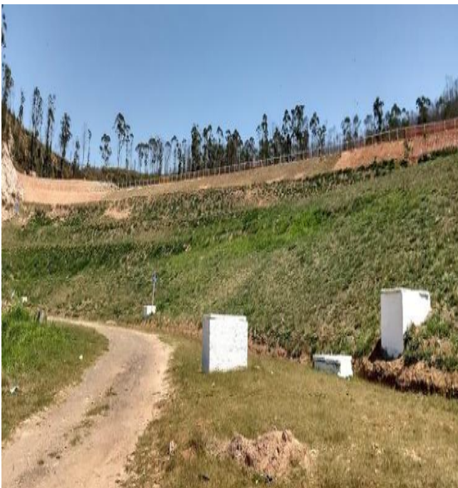
Foto 2: Células encerradas e revegetadas.
