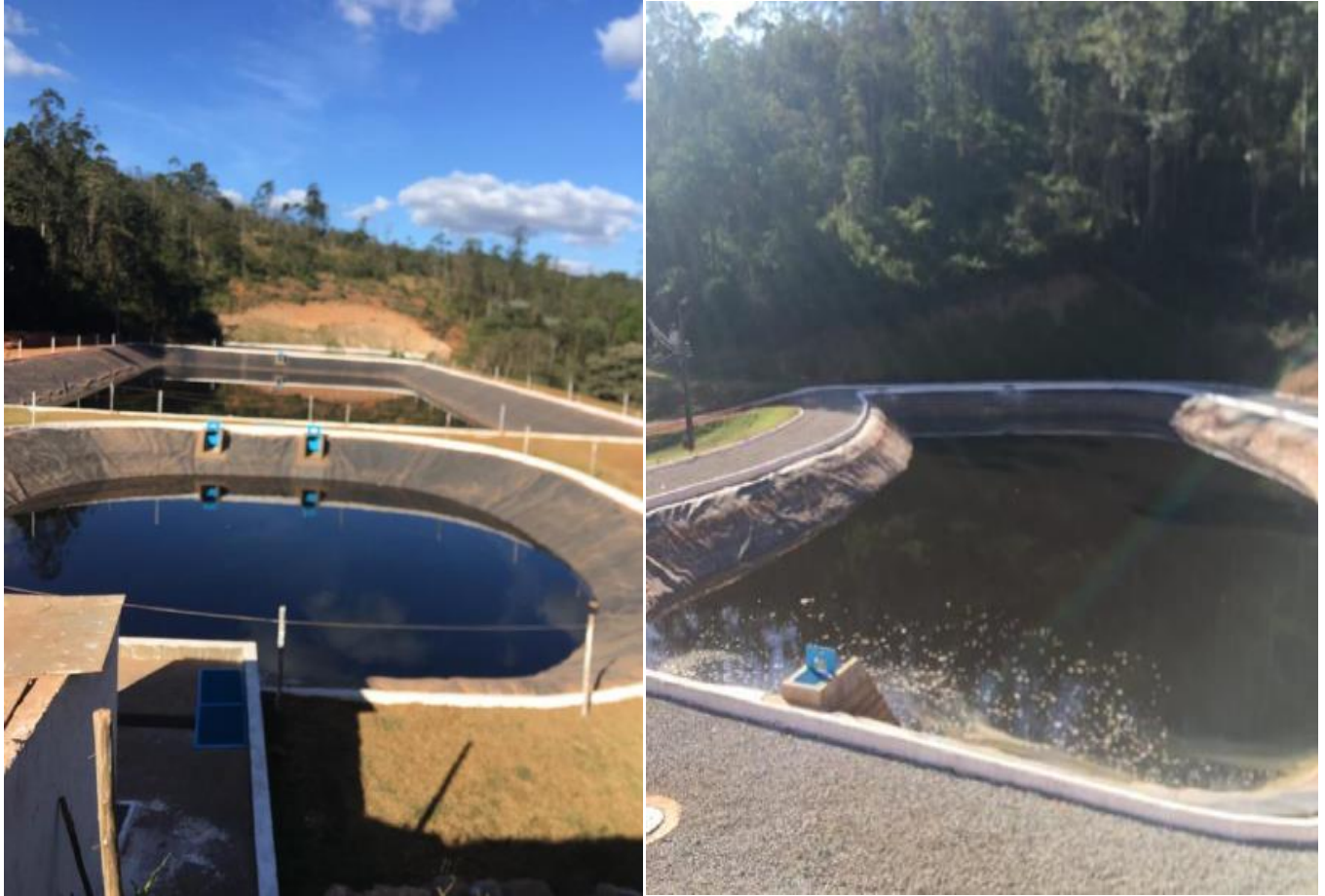
Figura 10: Lagoa anaeróbica seguida da lagoa facultativa após a reforma da impermeabilização. Figura 11: Nova lagoa de maturação.
