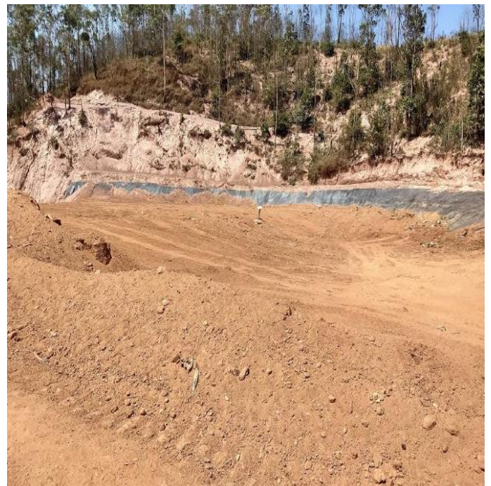
Foto 3: Recobrimento de célula do Aterro.
