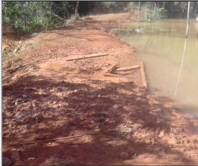
**Foto 1:** vista da crista do barramento com água passando por cima em alguns trechos.
