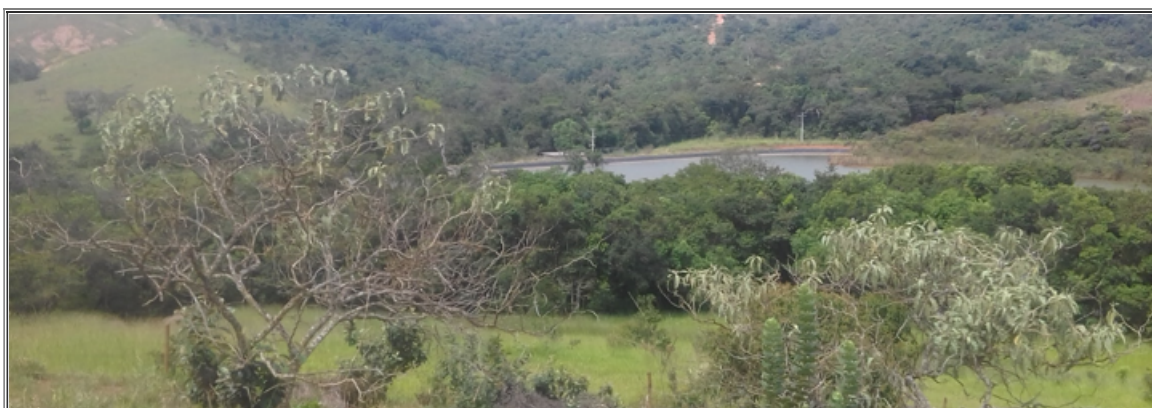
Foto 2: Vista ao longe do piscinão a ser regularizado.
