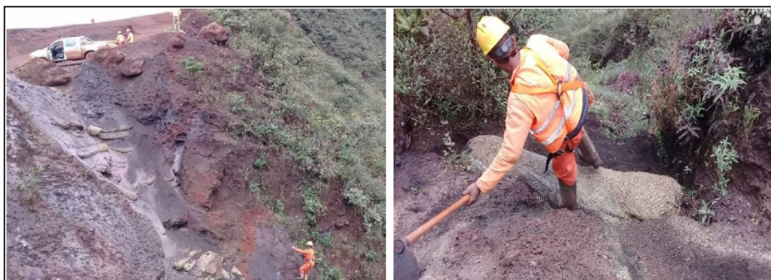
Figura 5.4.5- Ponto 1 - Preparo da área para aplicação de paliçada com bermalonga (fotos acima) e construção da paliçada com bermalonga (fotos abaixo).
