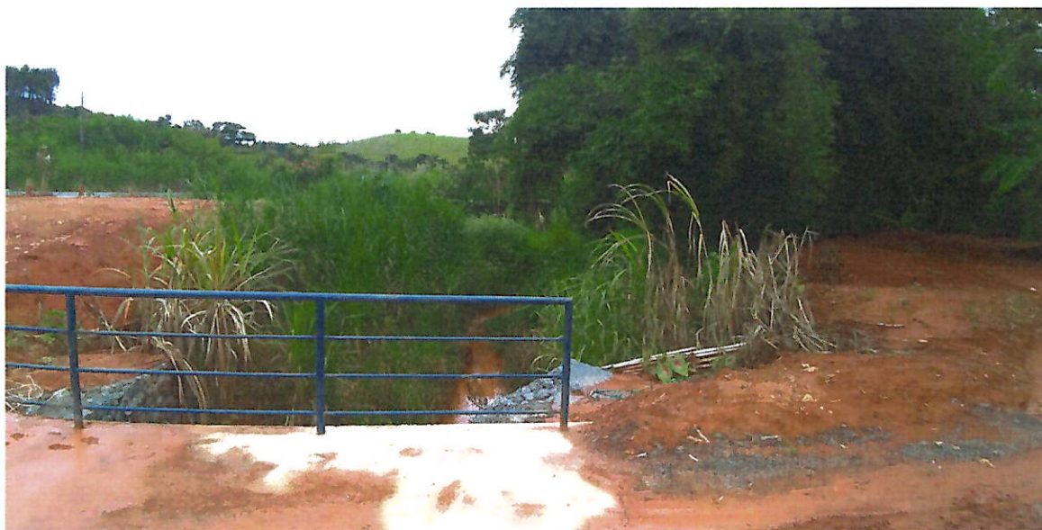
Foto 01: Demonstrando que o aterro foi realizado em toda extensão do imóvel, não apenas no encabeçamento da ponte.
