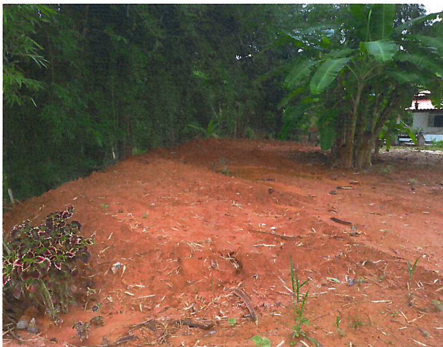
Foto 02: Aterro realizado à esquerda do córrego do coruja e não contemplado no levantamento topográfico apresentado nas informações complementares.
