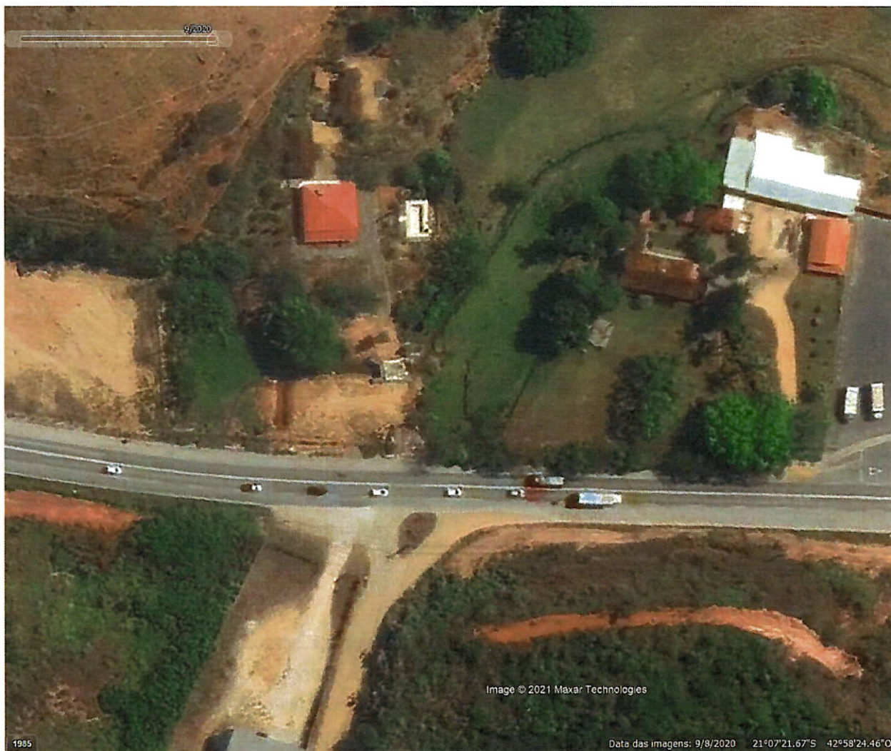
Foto 04: Imagem de satélite de 08/09/2021 onde já é possível verificar o aterro realizado no local.
