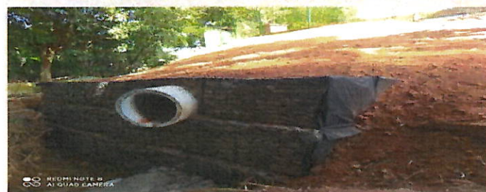
Foto 03: Muro de gabião pronto. Acima do muro de gabião, local reconstruído.
