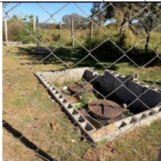
Foto 08: Biodigestores no Canteiro de Obras - Área da Fase I. Fonte: Relatório de Condicionantes (Junho/2025).
