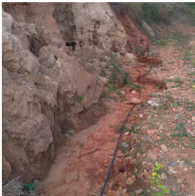
Foto 01: Demonstrando o canal de escoamento lateral da água provinda da nascente, assim como um cano de captação desta água.
