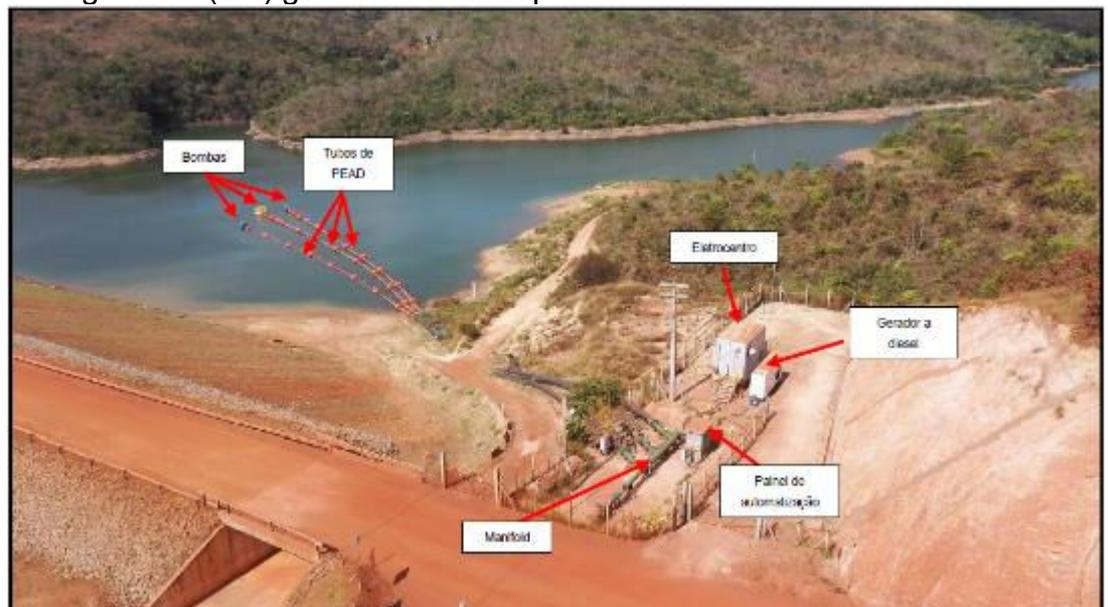
Figura 5- Estruturas para bombeamento
