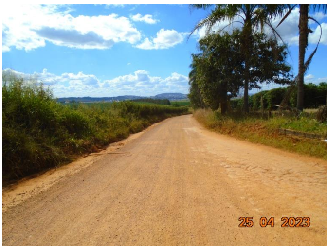
Figura 01: Vista da estrada.
