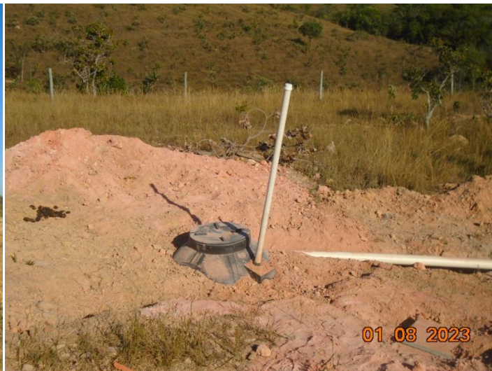
Foto 02: Fossa séptica em instalação
