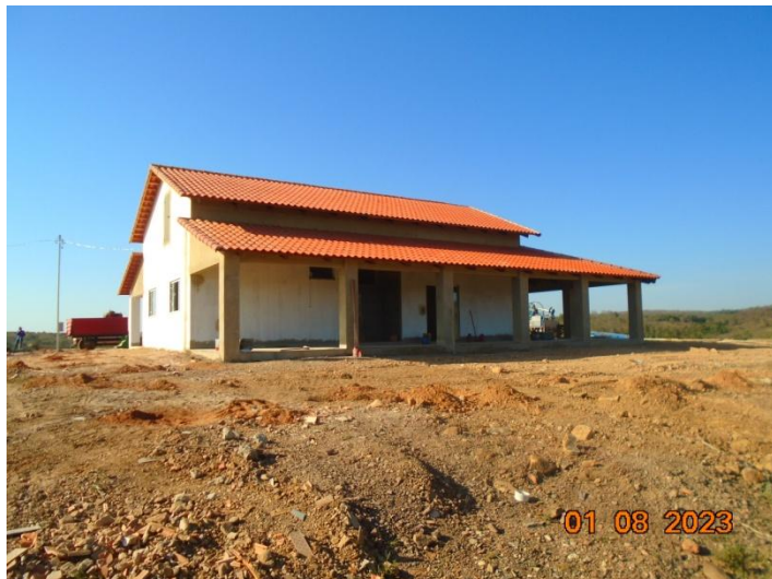
Foto 01: Residência em construção
