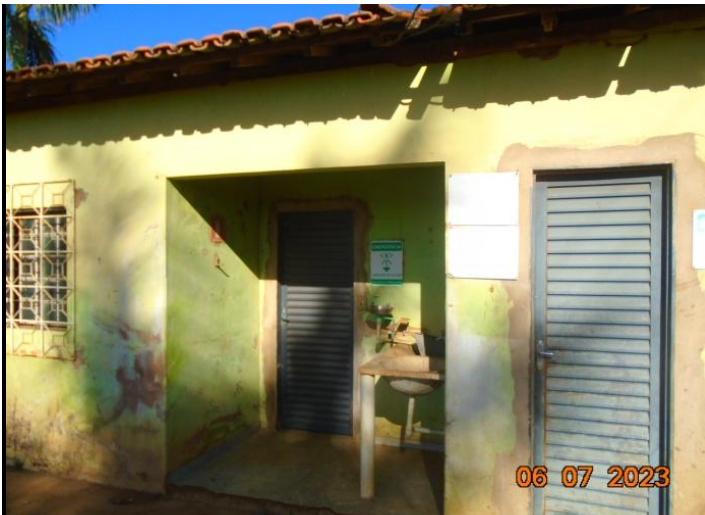
Depósito para armazenamento de embalagens cheias e vazias com lava-olhos
