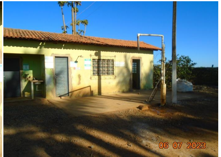
Área de preparo de calda impermeabilizada com caixa de contenção
