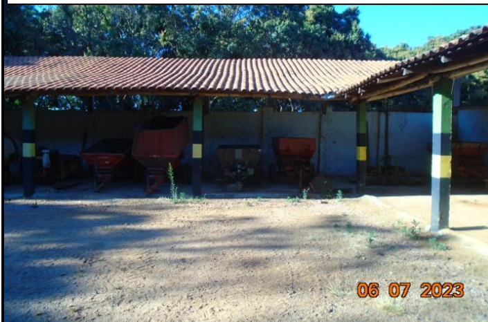
Área de disposição dos maquinários impermeabilizada com canaletas
