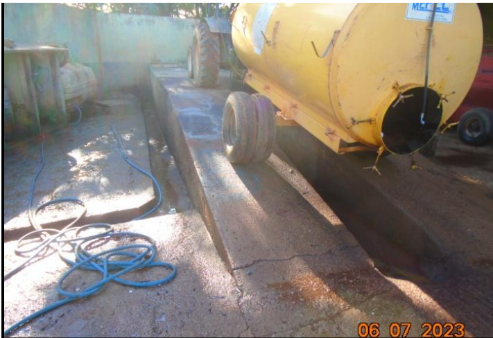
Área de lavajato impermeabilizada com canaletas
