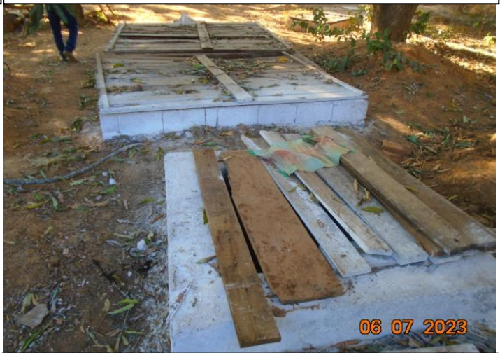
CSAO seguido de sumidouro
