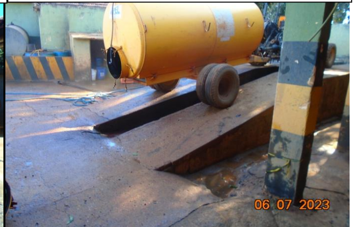
Área de lavajato impermeabilizada com canaletas
