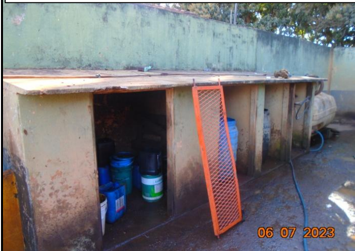
Área de disposição temporária de resíduos oleosos impermeabilizada e coberta
