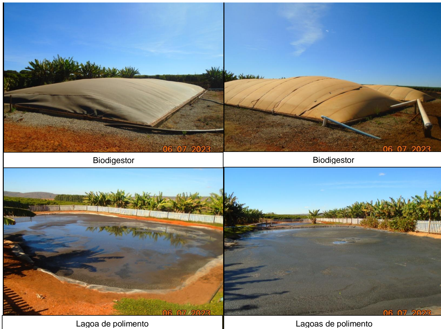
Figura 7 - Sistema de tratamento de dejetos da suinocultura
